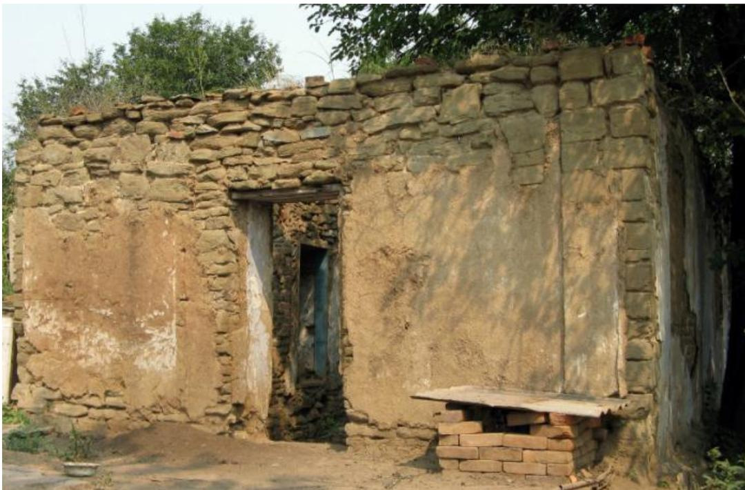
**Рисунок 29.** Пос. Старопетровское, ул. Пролетарская, к северу от дома № 156. Развалины постройки из дикого камня и старого кирпича. Судя по плану 1863 г., развалины относятся, скорее всего, к указанным на плане, как "каменные дома для помещения рабочих". 15 августа 2010 г. Фото А.Н. Усачука.
