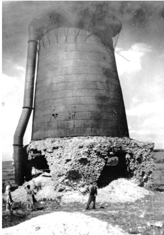
**Рисунок 13.** Старопетровский чугунолитейный завод. Кожух сохранившейся домны. Вид с юго-запада. Конец 40-х-начало 50-х гг. (?) XX в. Фотограф неизвестен.
